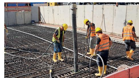
Deckelbetonung an der Gotthardstraße. Für den rund zwei Meter hohen Tunneldeckel sind große Mengen an Bewehrungsseilen und Beton nötig, 2024.
