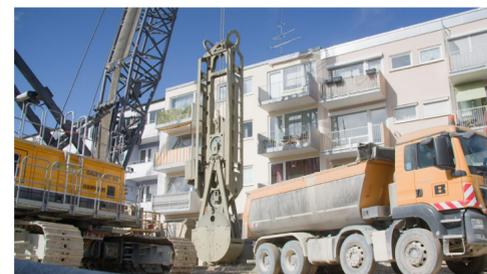
Ein Schlitzwandgreifer im Einsatz für die Außenwände der Tunnelstrecke unterhalb der Gotthardstraße, 2024.
