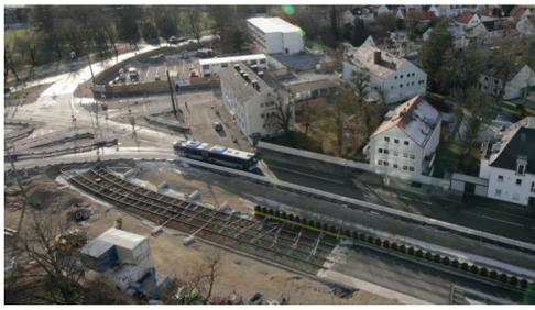
Im Bauablauf für den neuen U-Bahnhof Am Knie müssen die Trambahngleise temporär verlegt werden, 2024.
