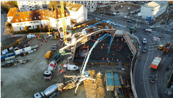
Blick aus der Luft auf die U5-Baustelle Am Knie mit dem Baufeld der künftigen U-Bahn-Station und laufenden Erd- und Spezialtiefbauarbeiten.
