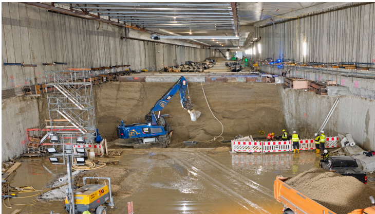
Blick auf den fertiggestellten Rohbau des Tunnelschachtes unter der Gotthardstraße, in deren Bereich der U-Bahnhof Baumschule Laim entstehen wird.
