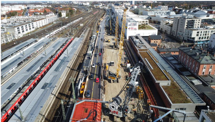
Blick auf die U5-Baustelle am Bahnhof Pasing: Im Vordergrund laufen die Spezialtiefbauarbeiten für die Herstellung der Baugrube.
