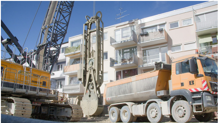
Ein Schlitzwandgreifer im Einsatz für die Außenwände der Tunnelstrecke unterhalb der Gotthardstraße, 2024.
