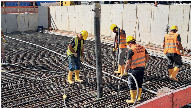
Deckelbetonage an der Gotthardstraße. Für den rund zwei Meter hohen Tunneldeckel sind große Mengen an Bewehrungsseisen und Beton nötig, 2024.
