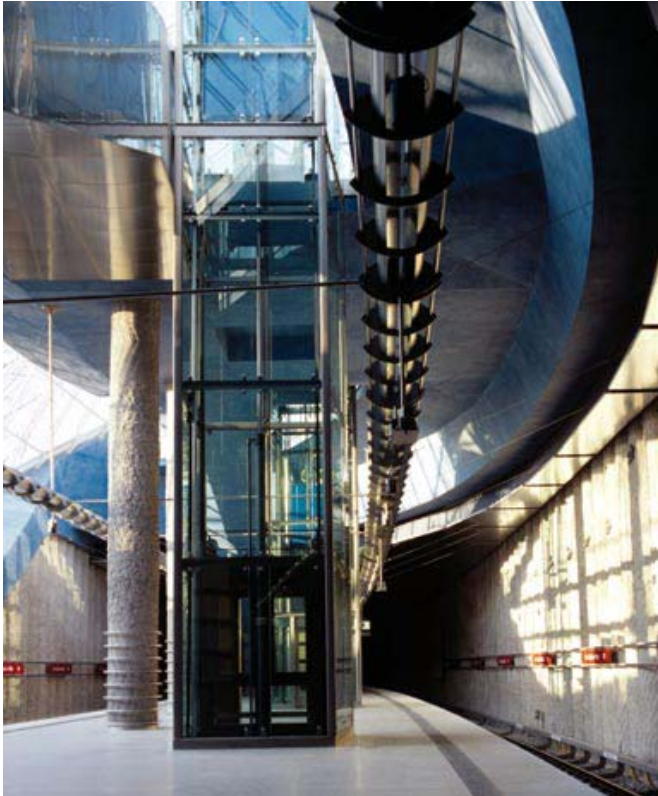
Die Glaskonstruktion über dem Bahnsteig stellte für die Ingenieure eine große Herausforderung dar. Sie überspannt neben Teilen des Bahnsteigs auch die mittig angeordnete, ebenerdige Schalterhalle, von der aus Fahr- und Festtreppen sowie Aufzüge zur Bahnsteigebene führen.
